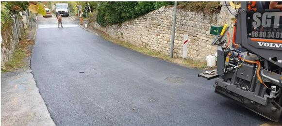
La pose de l'enrobée à l'entrée du village (côté du passage à niveau) vient combler... les nids-de-poule
