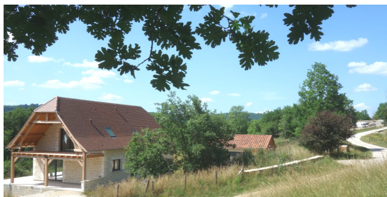
Le barry du Fraysse : 2 maisons en chantier
