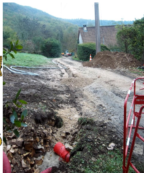
Enfouissement et renforcement des lignes électriques (moyenne tension), entre Pantalinat et La Martinie (450 m de tranchées)
