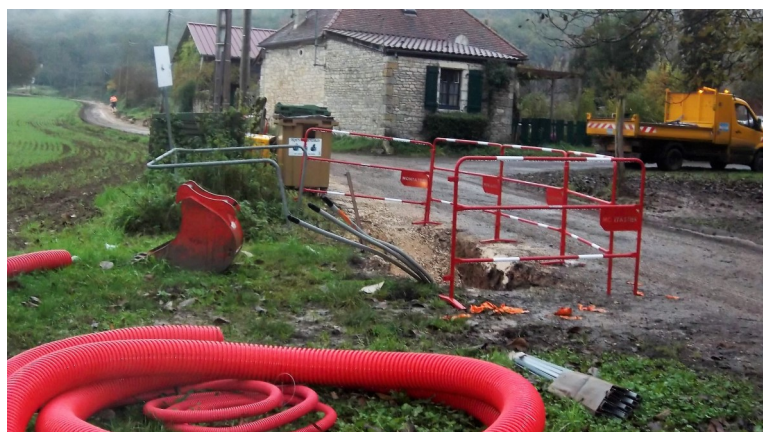
Enfouissement et renforcement des lignes électriques (moyenne tension), entre Pantalinat et La Martinie (450 m de tranchées)
