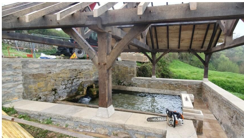
Le lavoir avant et après restauration de la charpente, de la toiture et du bâti, et nettoyé par des membres de l'AASF
