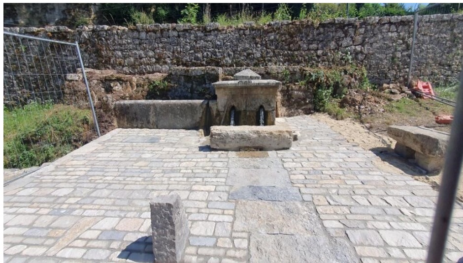
La fontaine St Georges, en cours de restauration
