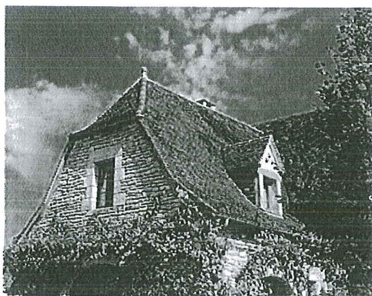
Figure 1 : Exemple de toiture typique
