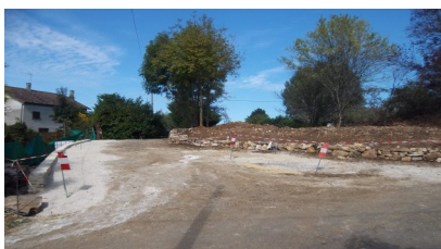
À Rul, mur de soutènement et élargissement du croisement
